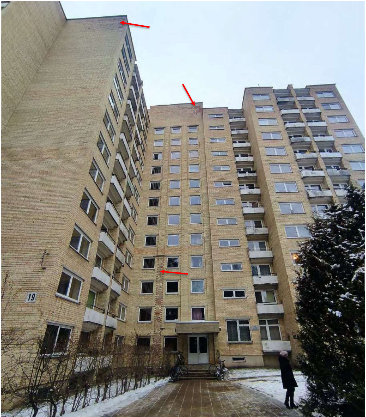
2 pav. Šiaurės-rytų fasadas (dalinai išardytas piliastras, erozijos pažeistas mūras)
