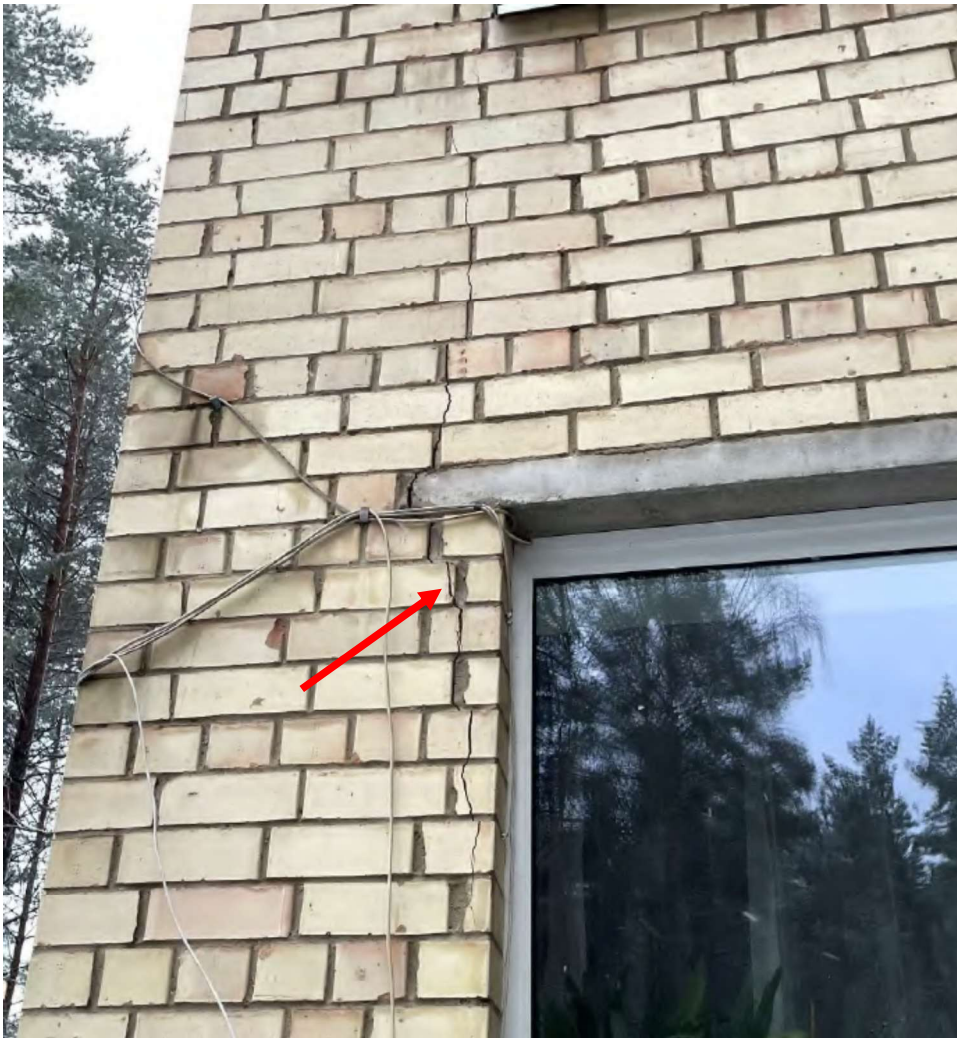
6 pav. Plyšys mūre ties saramos atrama
