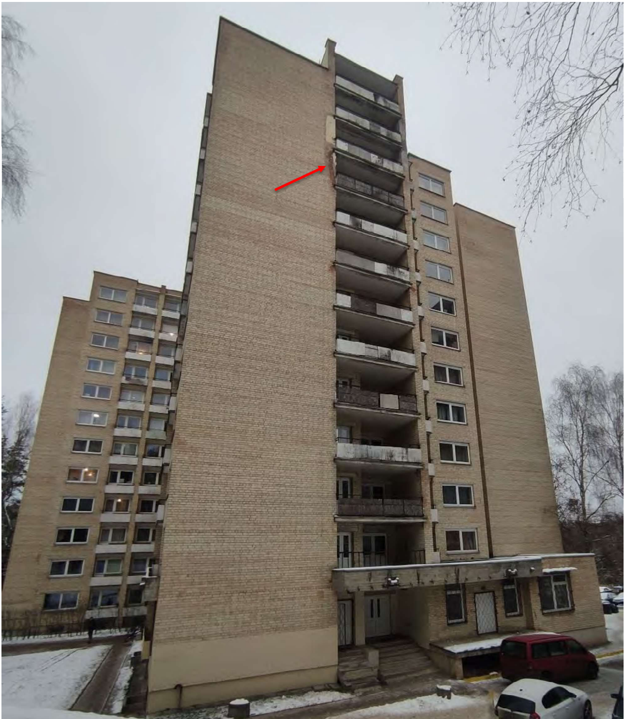
3 pav. Šiaurės-vakarų fasadas (erozijos pažeistas mūras)
