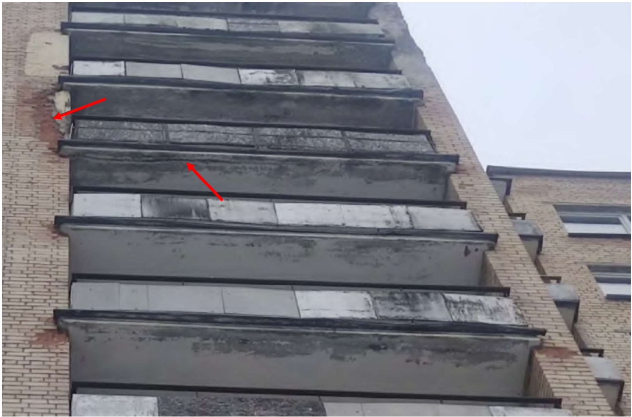
11 pav. Korozijos pažeista kiaurymėtoji perdangos plokštė, erozijos pažeistas mūras
