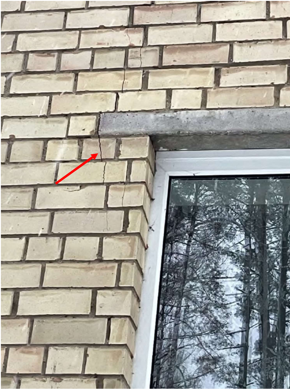
5 pav. Plyšys mūre ties sąramos atrama
