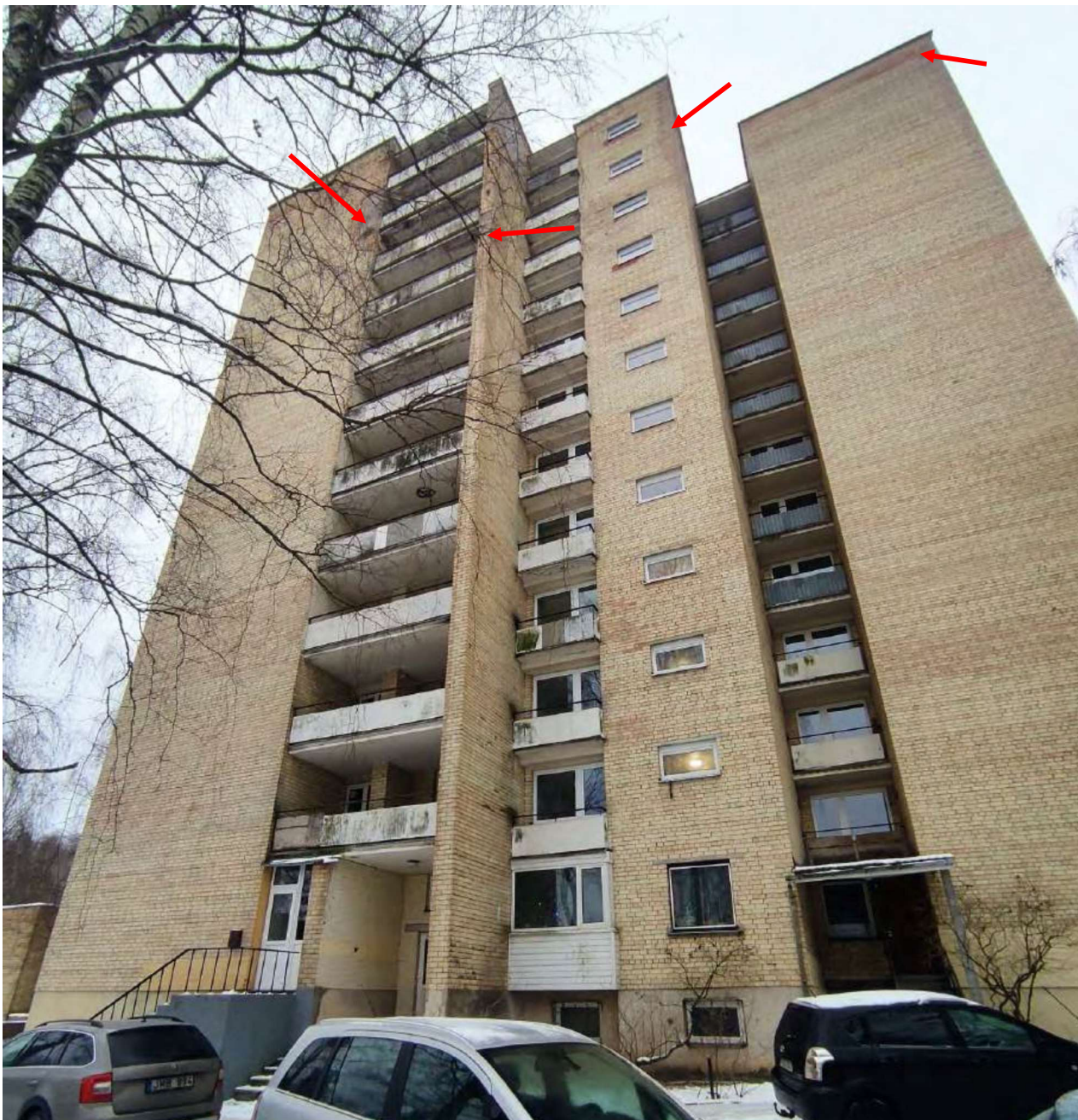
4 pav. Pietų-rytų fasado fragmentas (erozijos pažeistas mūras)
