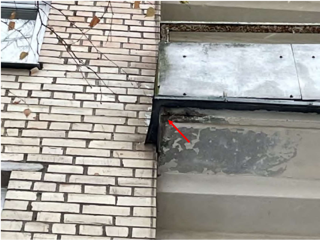
10 pav. Korozijos pažeista balkono plokštė
