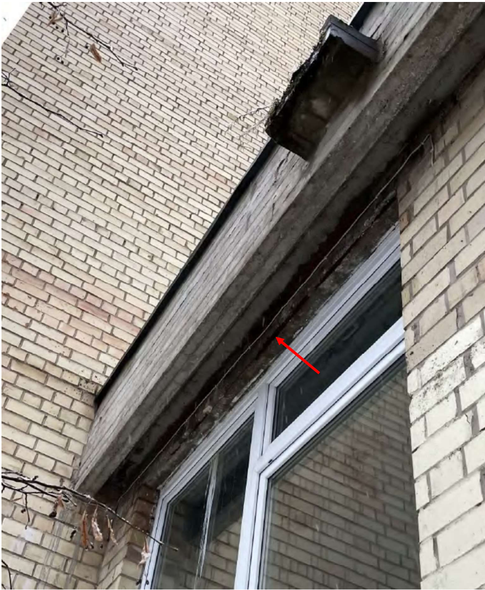
9 pav. Korozijos pažeista gelžbetoninė sąrama vakarinėje pastato dalyje
